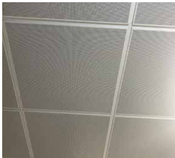
Riscaldamento/raffrescamento a soffitto ispezionabile e modulare
