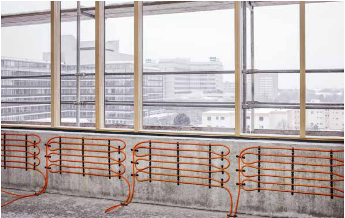
Sistema a parete costruito a umido che prevede l'utilizzo del binario di fissaggio REHAU 10 e del tubo RAUTHERM S.
