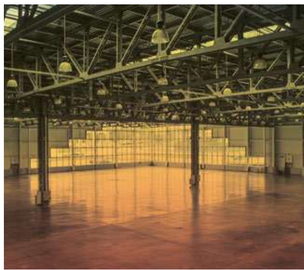
Termografia riscaldamento a pavimento
